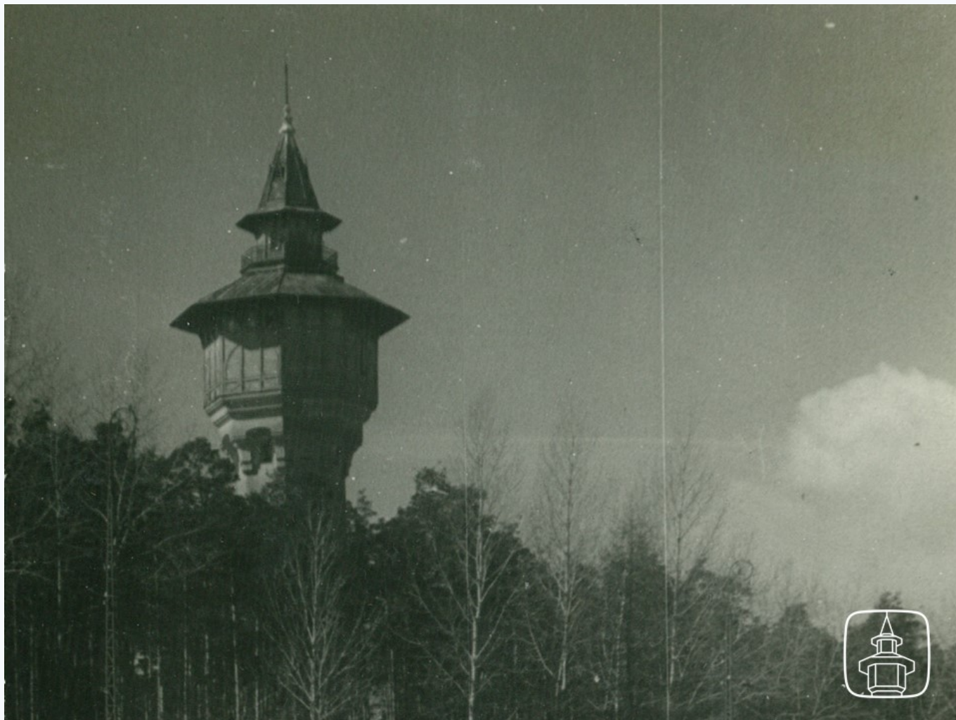
Вид на Гидробашню. 1943 год.
