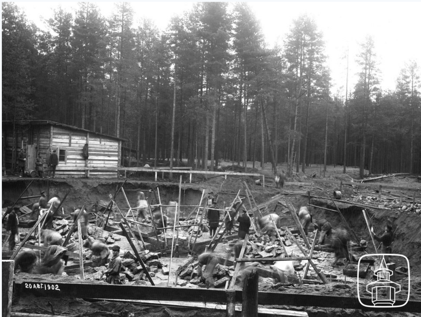
Закладка фундамента. 20 августа 1902 г.
